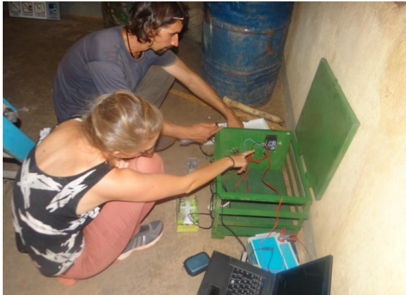
Die beiden SEWA-Praktikanten installieren die Handysteckdosen an der Batteriekiste.
