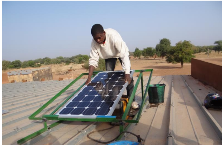
Die Module werden auf dem Dach montiert und dort fest verschweißt
